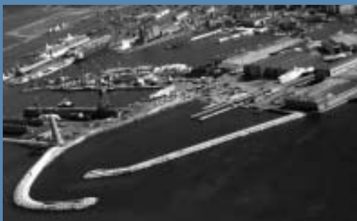
Area portuale livornese con il faro ed il cantiere.
