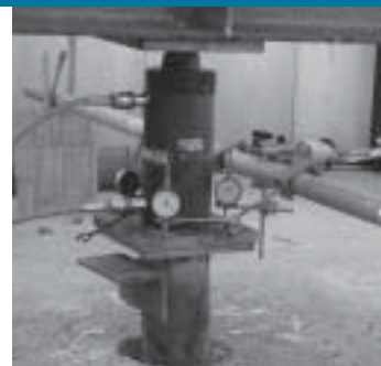
In alto a sinistra: tecnici specializzati di Frangerini Impresa, mentre effettuano un consolidamento con fibre in carbonio, durante il restauro del Teatro Goldoni di Livorno. A destra: opera di rinforzo della tessitura muraria della Fortezza Nuova. Foto piccola: prove di carico per verificare la tenuta di una struttura.
