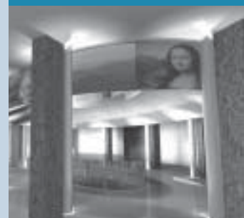
Foto in alto da sinistra: pinza utilizzata per effettuare le demolizioni in prossimità dell'atrio, in modo da rendere le stesse più contenute e controllabili. L'ultima capriata da demolire sul lato Astoria imbracata con dei teli per contenere la dispersione delle polveri. Galleria dell'atrio che sarà recuperata. Rendering che ritrae il piano terra dell'atrio, futura parte centrale della galleria commerciale
